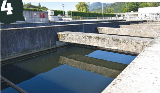
In der letzten Station des Abwassers lagert sich der Schlamm inklusive der Bakterien am Boden ab. Dieser Klärschlamm wird dann zum Teil wieder zurück in das Belebungsbecken gepumpt, um dort erneut zu „arbeiten“. Das gereinigte Abwasser läuft im Anschluss, nach entsprechender Analyse, in den Inn.
