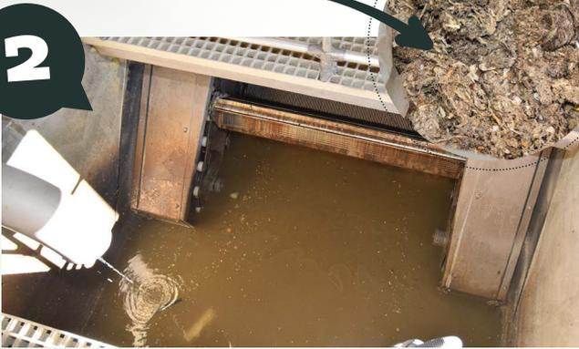
Der erste Schritt des Aufbereitungsprozesses ist die Entfernung von Feststoffen, die eigentlich nicht in das Abwasser gehören. Dazu läuft das Abwasser über ein Sieb mit 4 mm Spaltbreite. Zurück bleibt eine beträchtliche Menge an Müll, der als Restmüll entsorgt werden muss.
