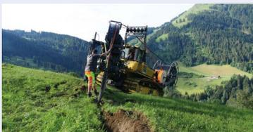
Mit einem Kabelpflug werden die Leitungen für Strom und Breitbandinternet im Erdreich verlegt.
