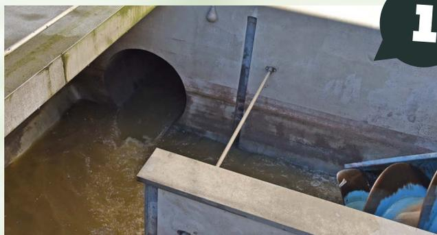
Über den Zulauf gelangt das Abwasser in die Kläranlage. Dort befinden sich Schneckenpumpen, welche das Abwasser auf das Niveau der Anlage heben, damit es dann die restlichen Stationen der Kläranlage durchlaufen kann. Je nach ankommender Abwassermenge sind bis zu vier Pumpen gleichzeitig in Betrieb.
