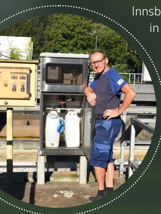
Betriebsleiter Reinhard Pfluger beim Automaten, der die Zulaufproben entnimmt.
